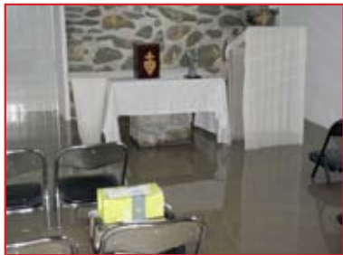
Inondation de la chapelle.
