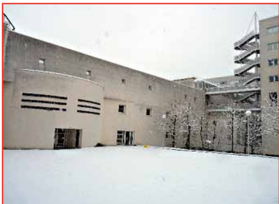
2010 - Extérieur de la chapelle, ouvrant sur le parvis revêtu d'un tapis de neige
